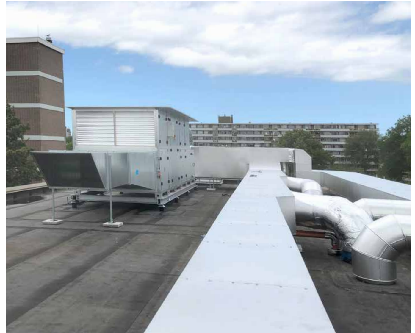
De luchtbehandelingsunit van de nieuwbouw, op bouwdeel B. (Beeld: Western Airconditioning)
