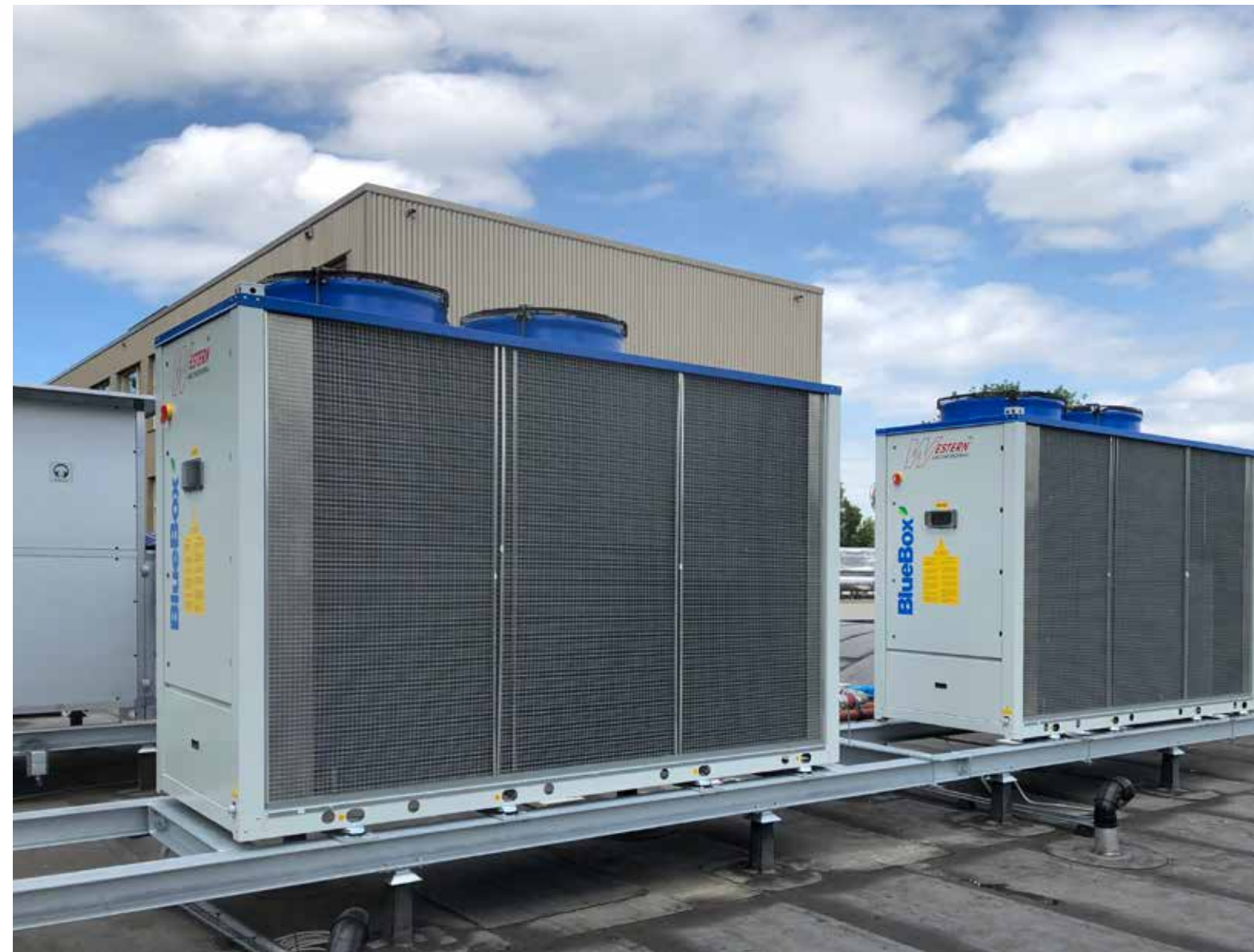
Twee lucht/water-warmtepompen op bouwdeel A. (Beeld: Western Airconditioning)
